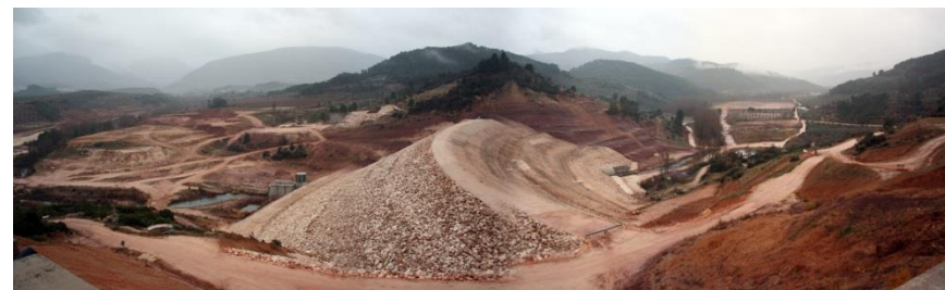
Presa de Siles
